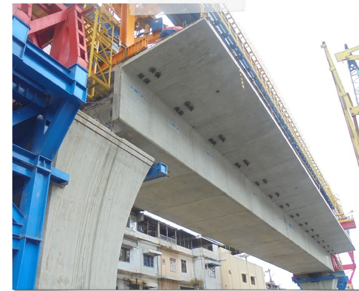
JALAN LAYANG KERETA API MEDAN - KUALANAMU
